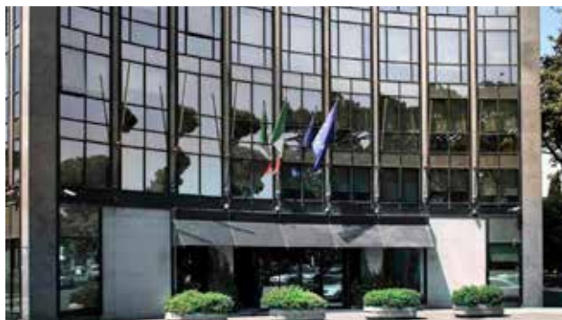
Sede Finmeccanica (Roma – Italia) Equipos: enfriadora RGA
