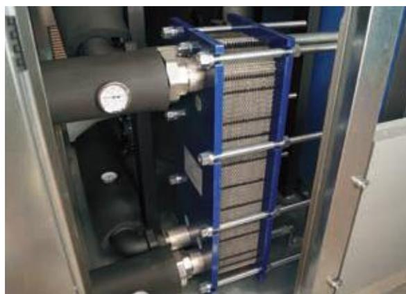
Equipo ROOF TOP con intercambiador de placas.
