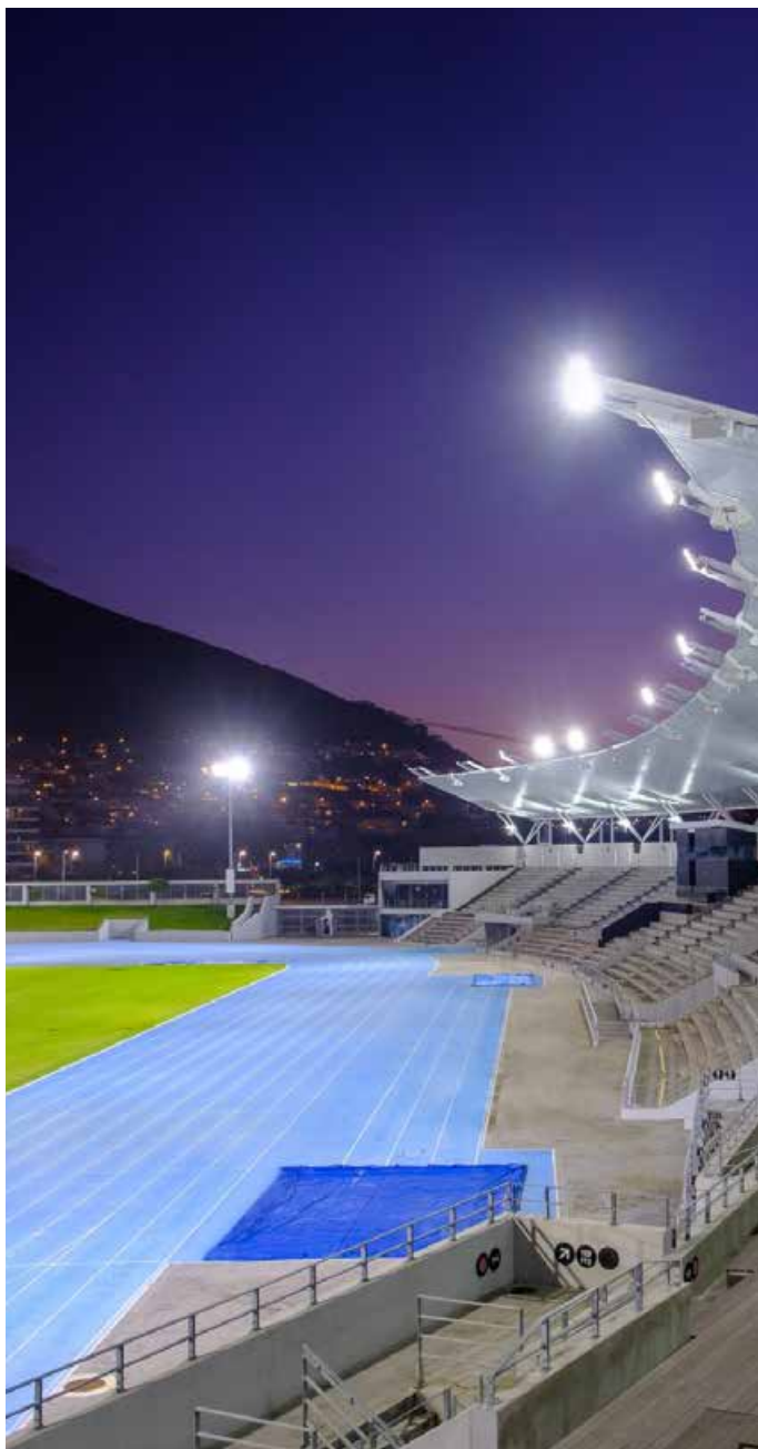
Green Point Athletics Stadium, Ciudad del Cabo (Sudáfrica). Producto: OMNIBLAST
