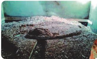
Los removedores simples A260 incorporan un agitador con dos aspas para combustible con facilidad para apelmazarse, como la astilla, y un canal con sinfín para la salida del combustible desde el silo. Todo ello gobernado por un único motor situado en la parte exterior del silo para un fácil mantenimiento.
