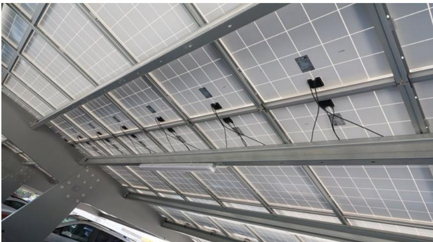
CORREAS DE SUJECIÓN Y PERFILERÍA DE ALUMINIO, DISEÑADA PARA LA CANALIZACIÓN DEL CABLEADO ELÉCTRICO. ÓPTIMA INTEGRACIÓN DE LOS MÓDULOS FV Y MÁXIMA ESTANQUEIDAD DEL SISTEMA.
