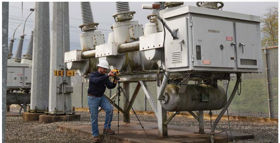
Un inspector utiliza el detector de gas Fluke Ti450 SF6 para inspeccionar conexiones atornilladas.
