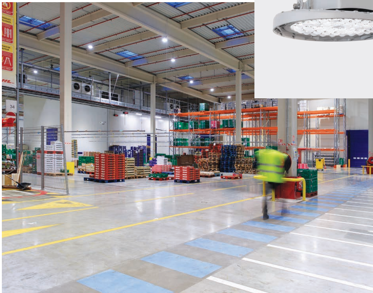
2018: Centro de distribución de Carrefour - Cestas, Francia
