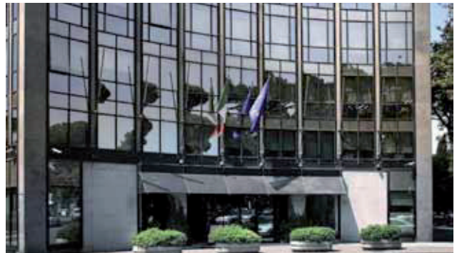
Sede Finmeccanica (Roma – Italia) Equipos: enfriadora RGA
