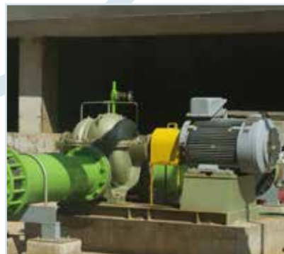
Control de bombas
