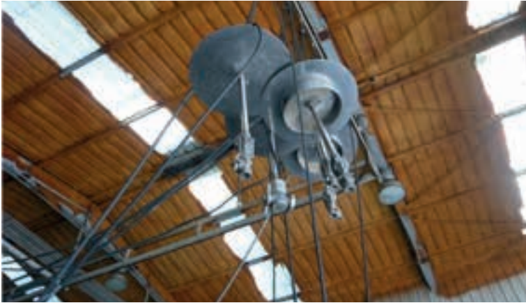
Foto 8.3. Sistema de lavado industrial de depósitos (59-60°C)
