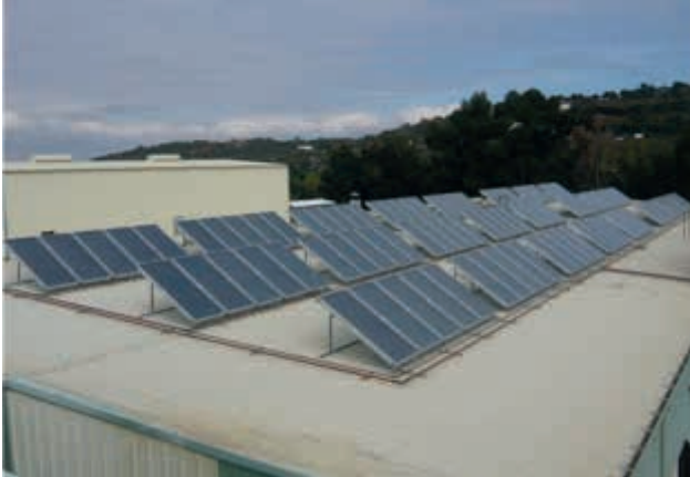
Foto 8.6. Campo de colectores solares (252 m 2 ) en sector alimentación.
