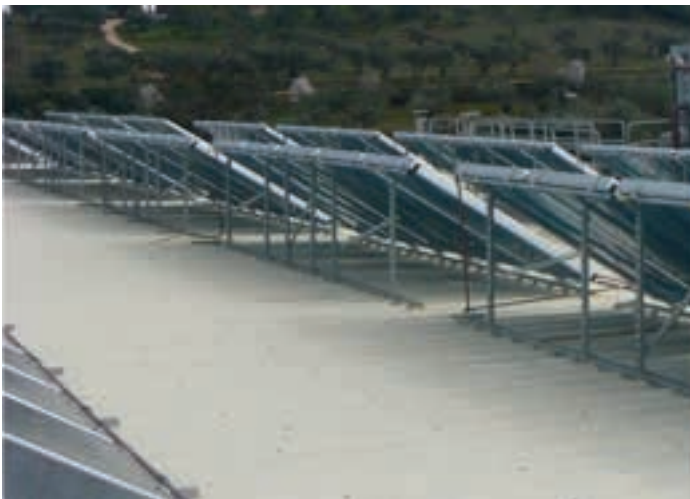
Foto 8.1. Instalación solar térmica aplicada a proceso industrial.
