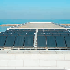
Figura 8.14. Diseño de sistema solar para secado convectivo válido para el caso de este ejemplo. No existe almacenamiento, rango de caudal másico de 20 kg / (h*m 2 Ap ) a 100 kg / (h*m 2 Ap ).
