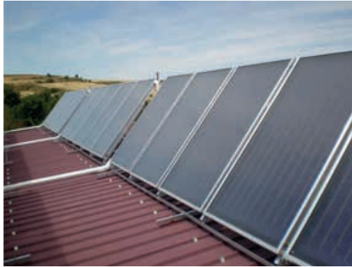
Foto 8.8. Campo de colectores solares (525 m 2 ) en industria química.
