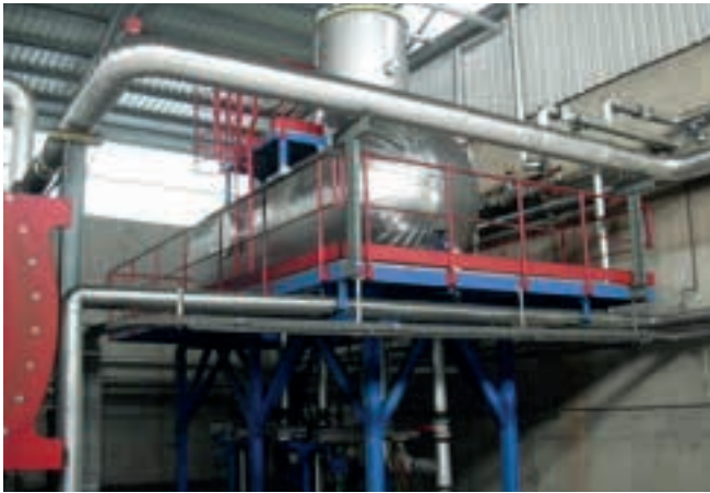
Foto 8.4. Sistema de vapor industrial (180 °C) semi-abierto.
