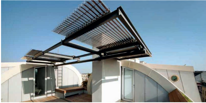
Foto 10.2. Posibilidades de montaje. Colectores de vacío (heat pipe).
