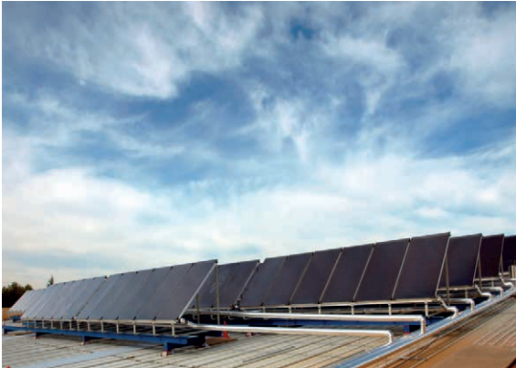
Figura 2. Instalación deportiva en Móstoles resuelta con sistemas Drain Back (340 m 2 de superficie de captación).
