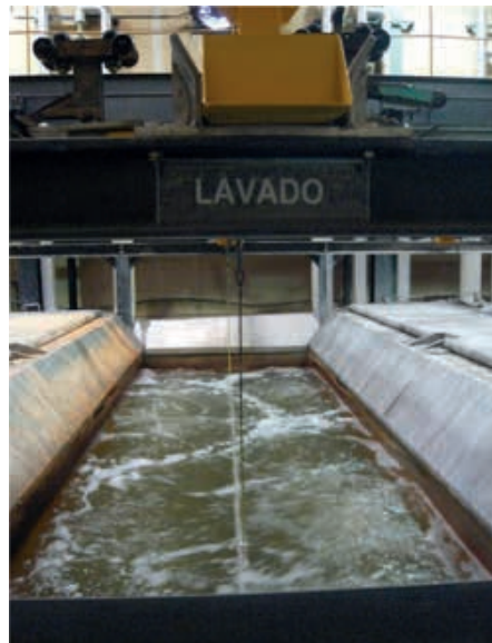
Foto 8.2. Proceso de lavado con aporte solar térmico
