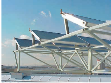
Foto 10.1. Posibilidades de montaje. Colectores planos.
