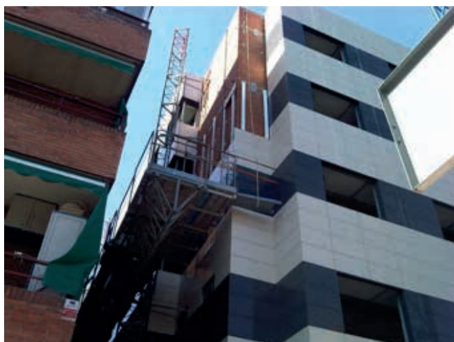
Foto 6.1. Instalación realizada (I).
