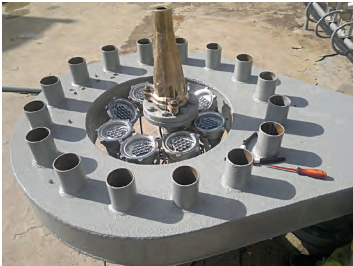
Figura 3. Montaje de proyectores LED en el surtidor de la fuente. Fuente: empresa IMESAPI, S.A.
