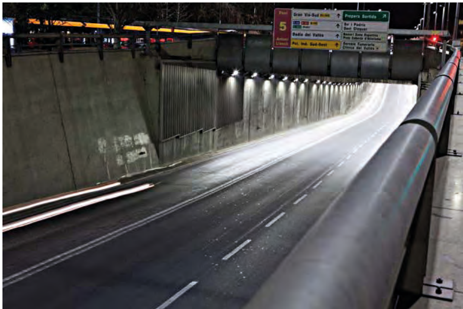
Figura 11. Iluminación de túneles.
