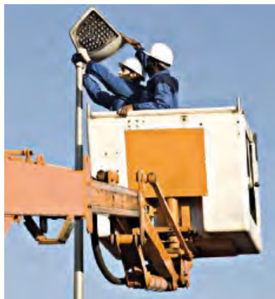
Figura 8. Mantenimiento de luminarias.
