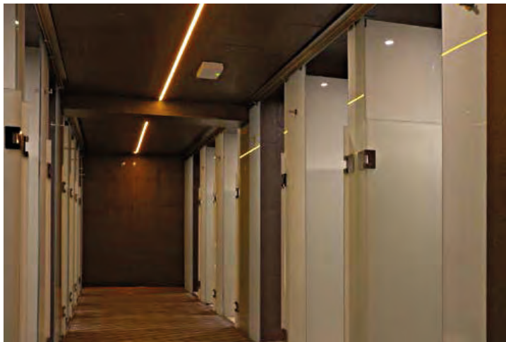
Figura 33. Ejemplo de iluminación de emergencia con LED.
