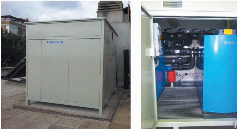
Fotografía 1. Fotos de ubicación de las calderas en la azotea del edificio. Fuente: Buderus.
