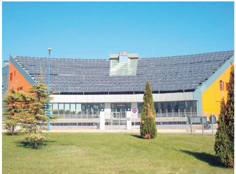
Foto 1. Instalación solar fotovoltaica integrada en edificio de una empresa. Fuente: ABACO AMBIENTAL, S.L.
