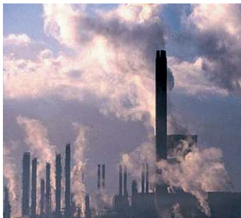
Fotografía 2. Torres de Centrales Eléctricas. Fuente: RTR Energía.
