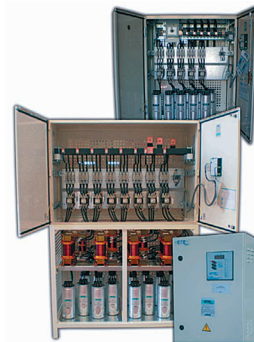
Fotografía 4. Cuadro eléctrico con baterías de condensación. Fuente: RTR Energía.
