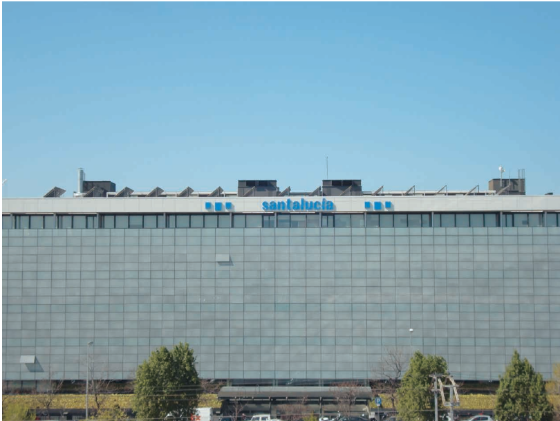
Foto 2. Instalación solar térmica en edificio de oficinas. Fuente: ABACO AMBIENTAL, S.L.
