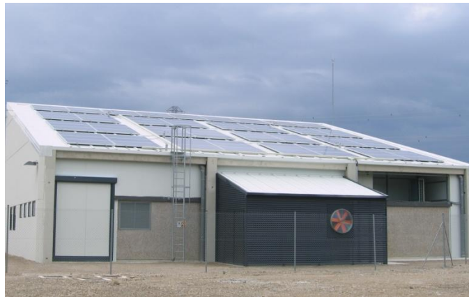
G- Instalación Fotovoltaica 25 kWp
