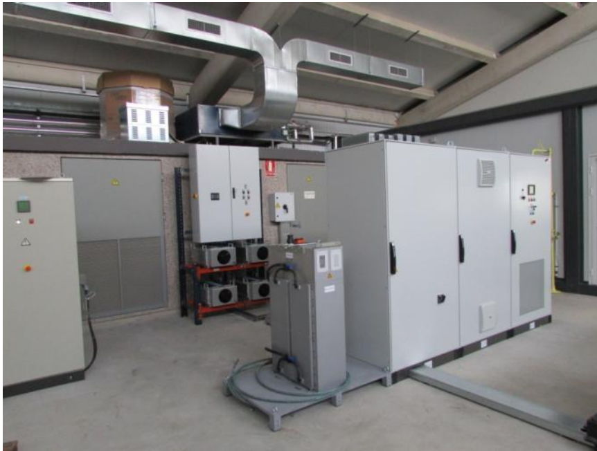
S- Baterías de Ion-Litio, 30 kW x 1/2 hora
