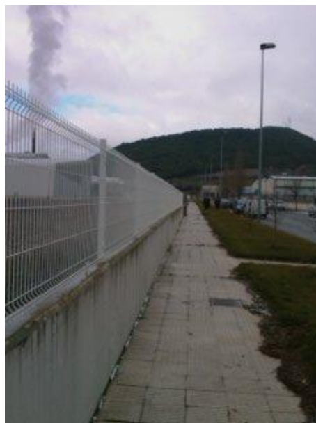
L- Luminaria del polígono industrial y oficinas - LEA -
