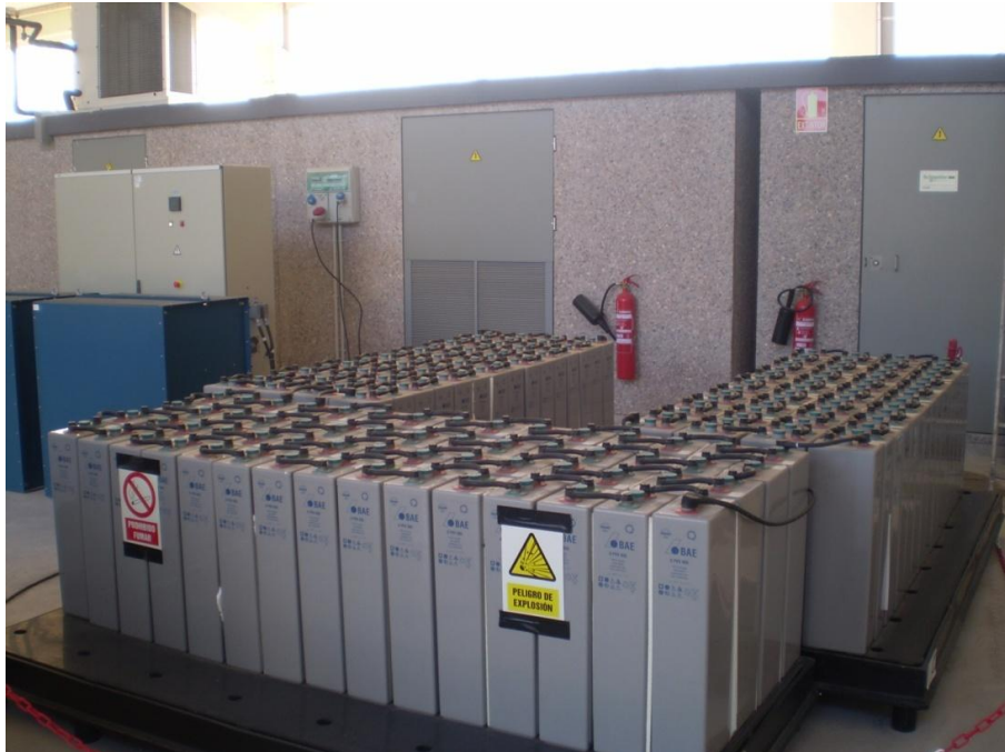
S- Baterías de Plomo-Ácido, 50 kW x 2 horas
