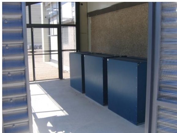
L- Cargas trifásicas 120 kVA
