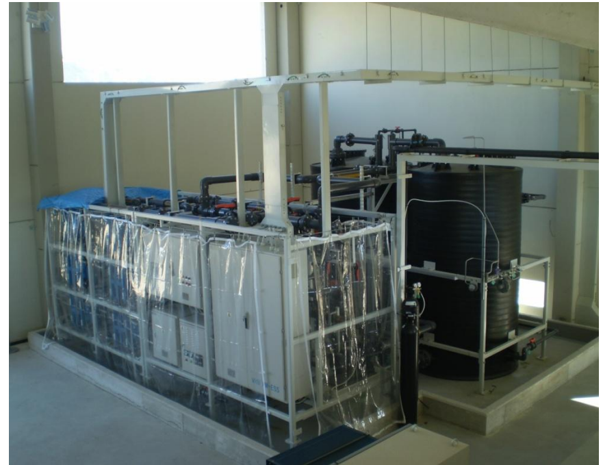
S- Batería de flujo, 50 kW x 4 horas
