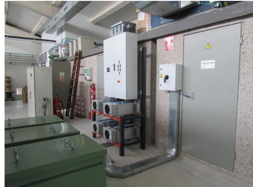
S- Supercondensadores 30 kW, 4 sg
