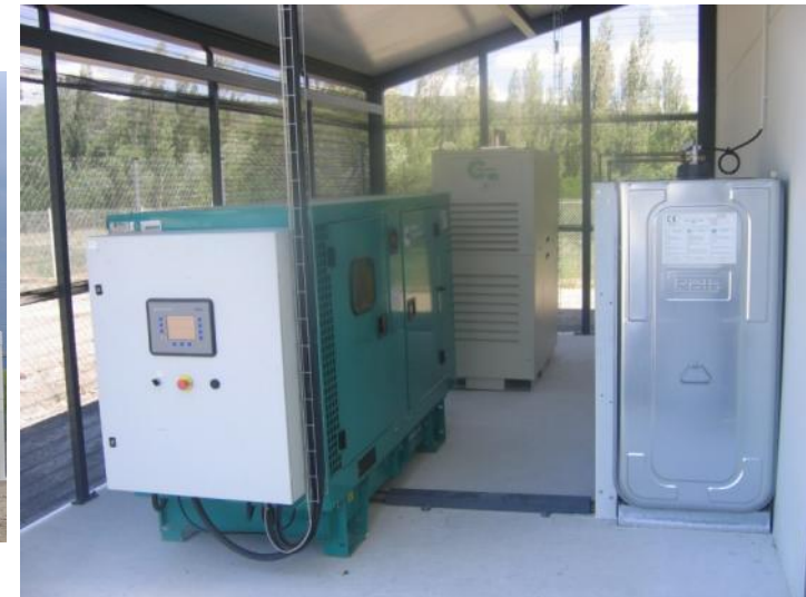
G- Generador Diesel 55 kVA y Microturbina de Gas 30 kW (además del aprovechamiento térmico)
