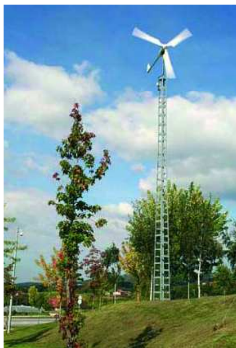
Ilustración 8.- Aerogenerador de 6 kW. Fuente: LABEN-TECNALIA
