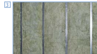
3 Colocación del aislamiento URSA TERRA.
