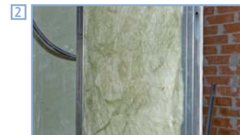
2 Colocación de las instalaciones.
