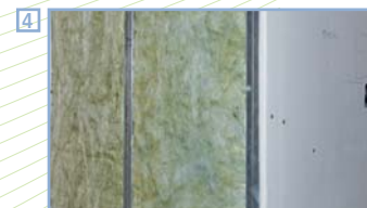
4 Colocación placas de yeso laminado.
