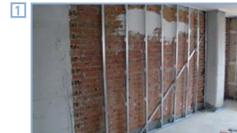
1 Instalación de la estructura de entramado.
